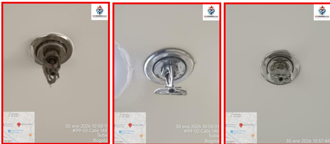
Fotografía: 10 Inspección de rociadores
