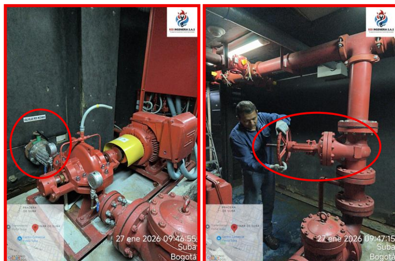
Fotografía: 3 Inspección válvulas en succión y descarga
