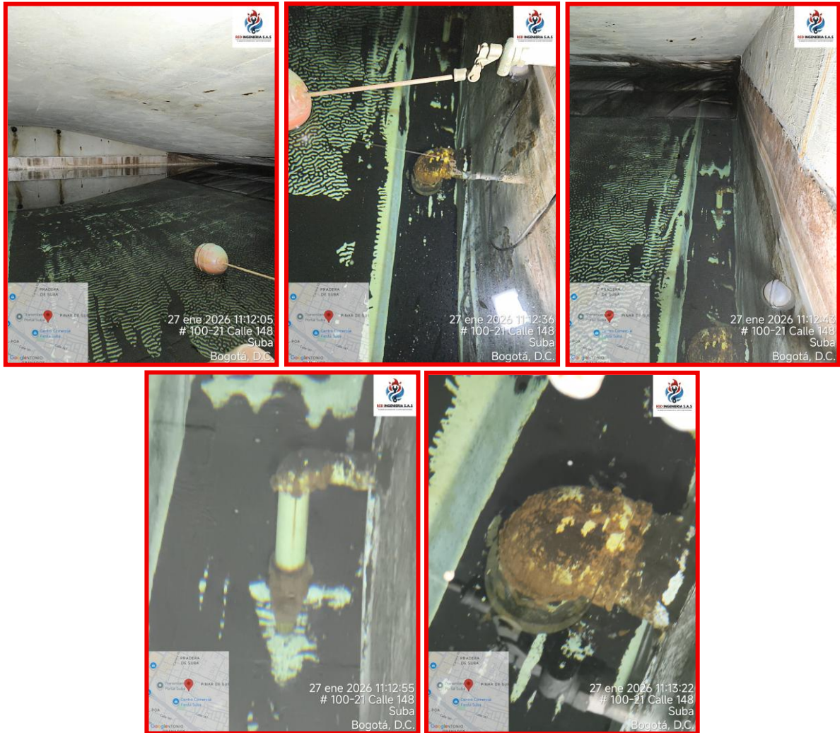
Fotografía: 1 Inspección sistema de abastecimiento de agua
