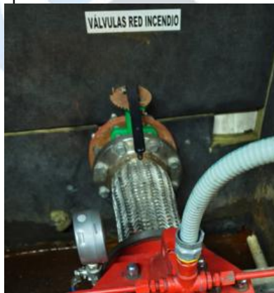
Imagen 8, válvula de succión.
